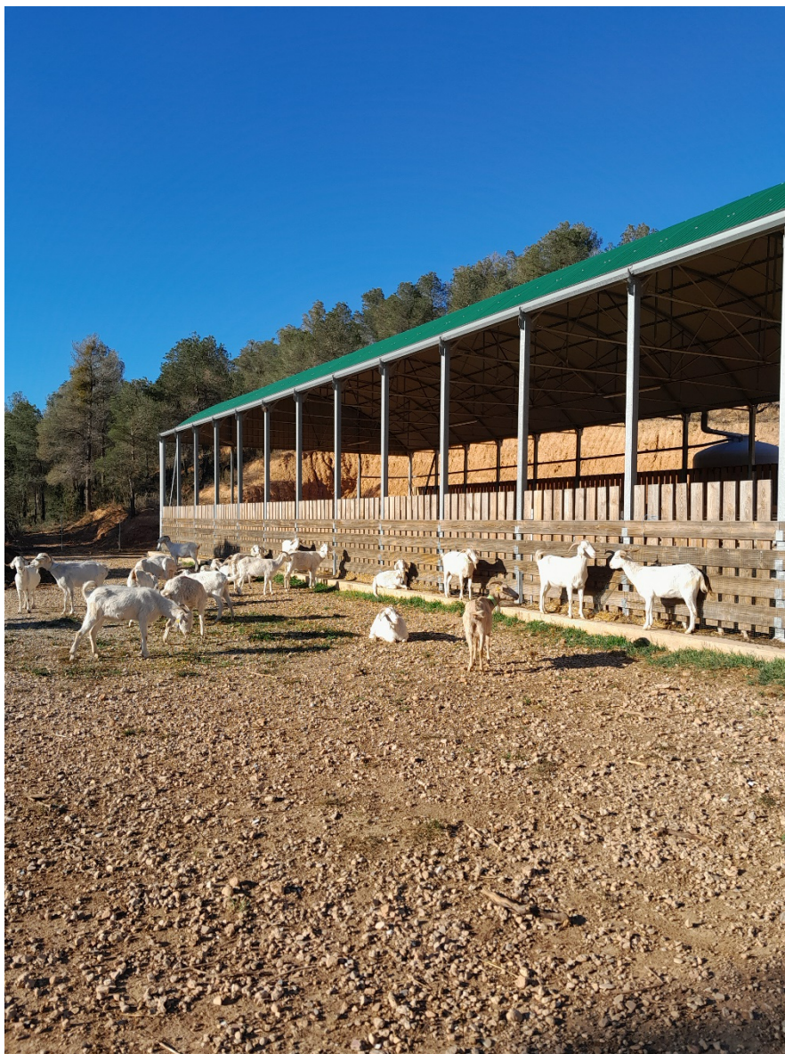
Figura 4. Vista exterior del corral de l'ET de Gandesa.
